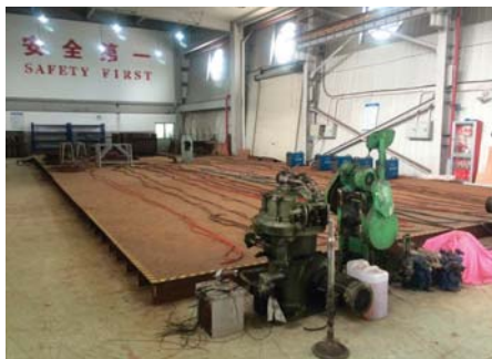
图3 钢制船体分段装焊实训平台
