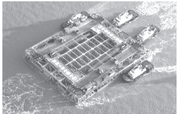
图3 钻孔平台实景俯视图
